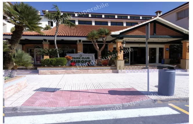
Rampa di raccordo con il marciapiede
